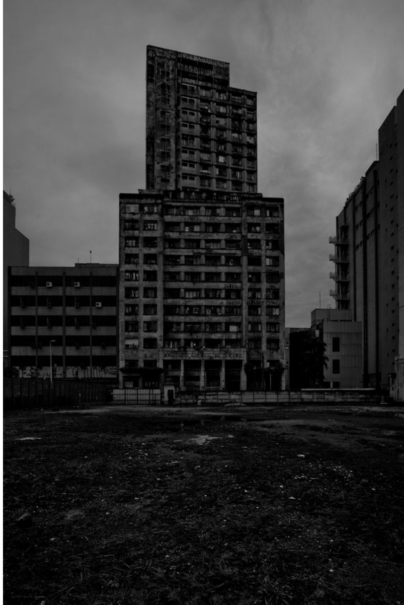
O edifício Prestes Maia, uma das maiores ocupações urbanas da cidade com 23 andares e mais de 400 famílias cadastradas.
